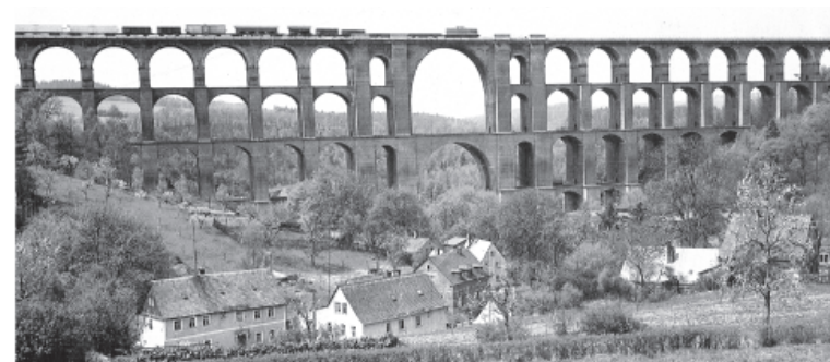
Рис.36. Железнодорожный мост («Гельцштальский мост») около г. Нетцшкау, Германия (1845—1851 гг.). Мост высотой 78 м и длиной 575 м. Конструкция его напоминает о громадных арочных сооружениях древних римлян. Это один из наиболее значительных мостов массивной конструкции из числа построенных в XIX в.; на его строительство было израсходовано 22 млн кирпичей
